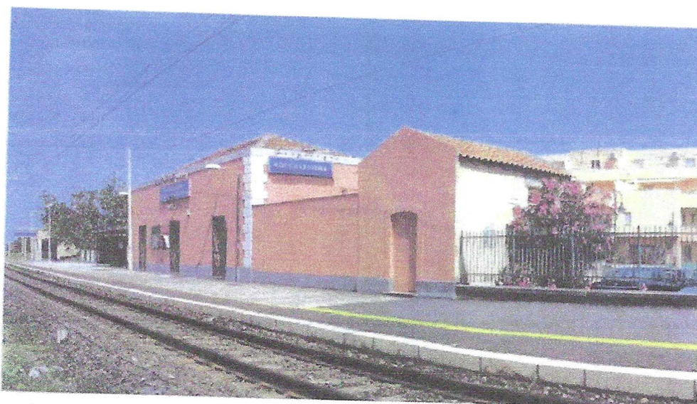
La stazione prima della dismissione
